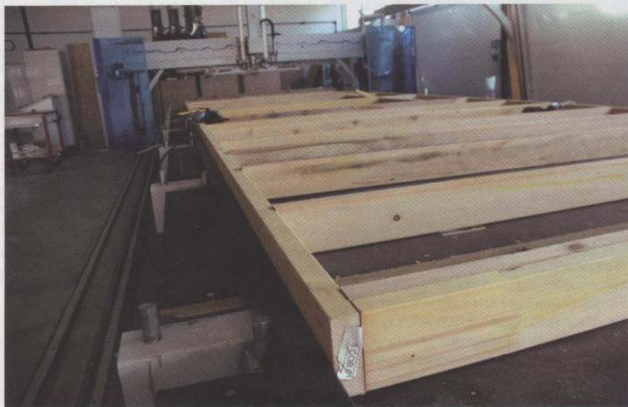
Fabrication de murs de maison à ossature bois avec une table Weinmann.
