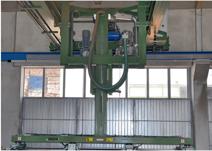
Eine Bewegung in Längs- und Querrichtung erlaubt der Portalroboter, um die Abstapelungspunkte in der Halle präzise zu bedienen
