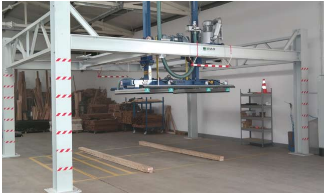
Rama maszyny przytwierdzona jest kotwami na stałe do posadzki.
